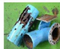
図4. 水制動機の出口パイプ
