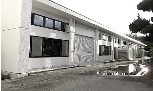
1 完成写真 (南側外観)
