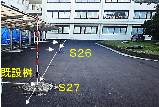
1 完成写真 （情報工学科棟南側） 污水管渠
