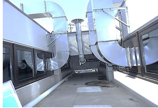
2 完成写真 (屋上外観_排気ダクト)
