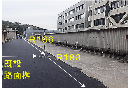
2 完成写真 （電子機械工学科棟北駐輪場） 雨水管渠
