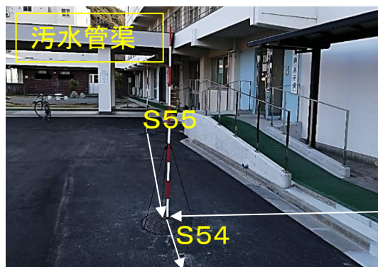
2 完成写真 （低学年棟入口附近） 汚水管渠・アスファルト舗装
