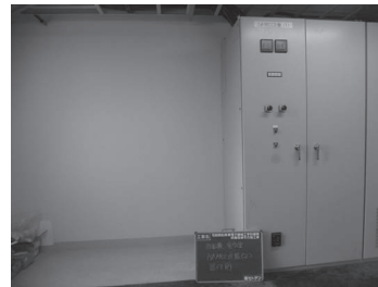
⑤着工前写真(電気室)
