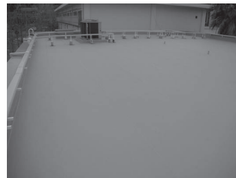
②完成写真(全景)
