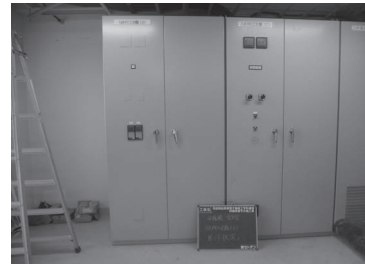
⑥完成写真(電気室)
