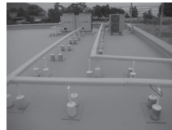
④完成写真(空調機廻り)
