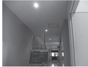
②完成写真(廊下)
