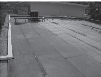
①着工前写真(全景)
