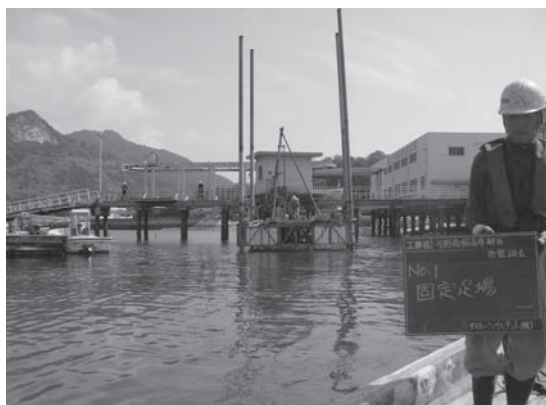
①NO. 1足場固定(ボーリング位置)
