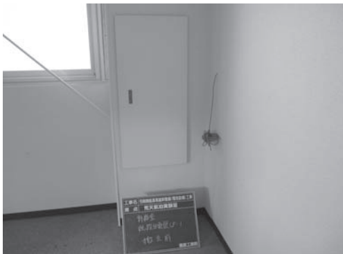
①着工前写真(計測室)
