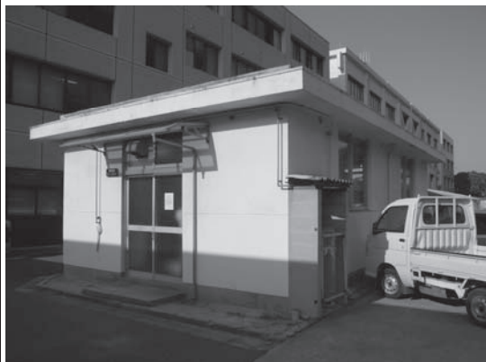
③着工前写真(第二技術班事務室外観)
