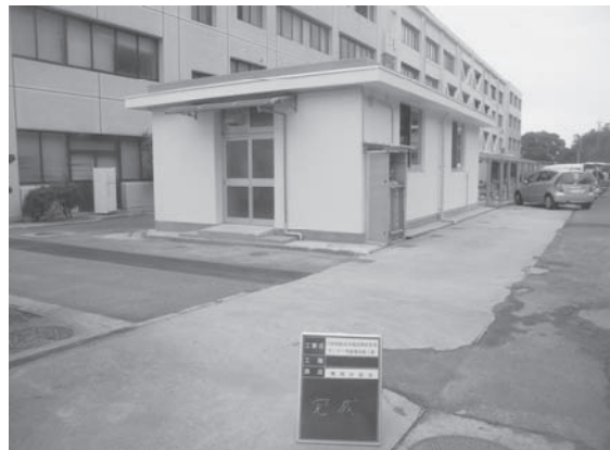
④完成後写真(第二技術班事務室外観)
