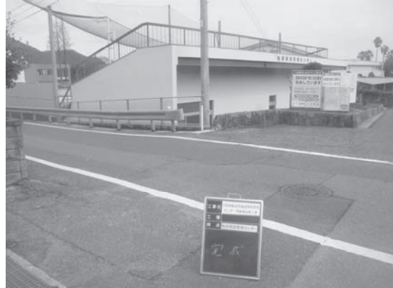
②完成後写真(施設開放管理センター外観)
