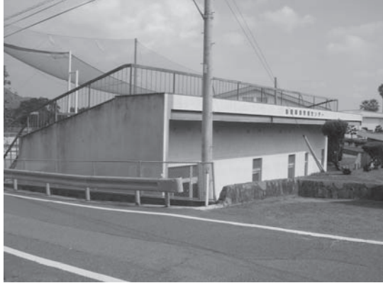
①着工前写真(施設開放管理センター外観)
