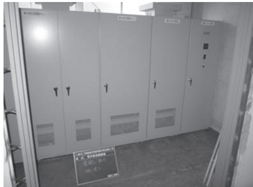
②完成後写真(受電室)
