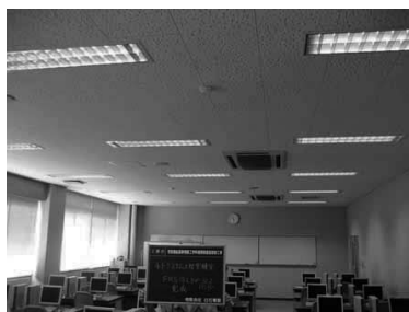
②着工後写真(照明器具)
