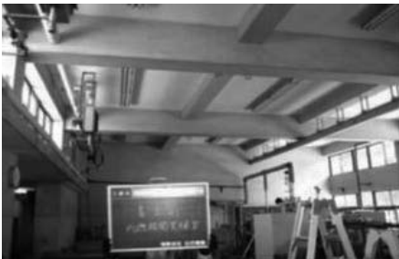
①着工前写真(照明器具)
