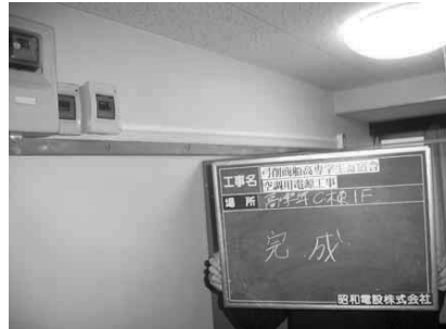
②着工後写真(コンセント増設)
