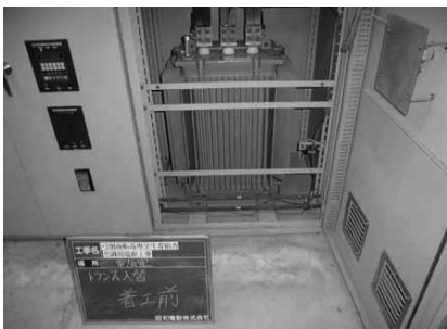
①着工前写真(変圧器取替)
