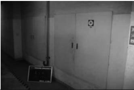
①着工前写真(分電盤)
