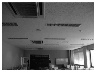
①着工前写真(照明器具)
