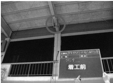
①着工前写真(ウインチ)
