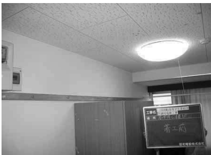
①着工前写真(コンセント増設)
