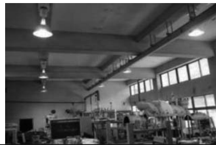
②着工後写真(照明器具)
