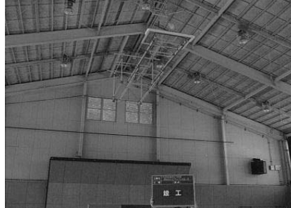
②着工後写真(バスケットゴール)
