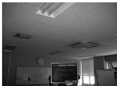
①着工前写真(照明器具)
