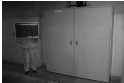
②着工後写真(分電盤)
