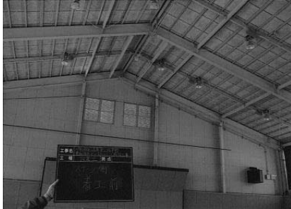
①着工前写真(バスケットゴール)
