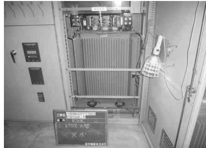
②着工後写真(変圧器取替)
