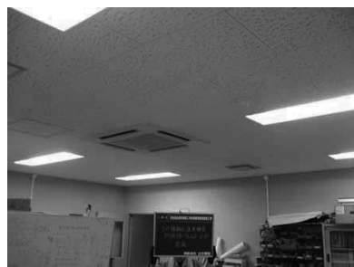
②着工後写真(照明器具)
