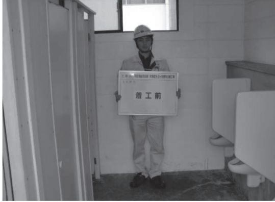
4-1 着工前写真(屋外便所)
