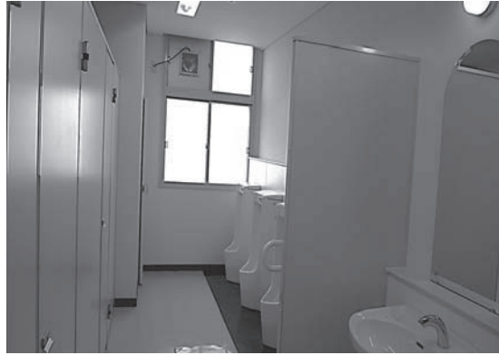
1-2 完成後写真(第1体育館男子便所)
