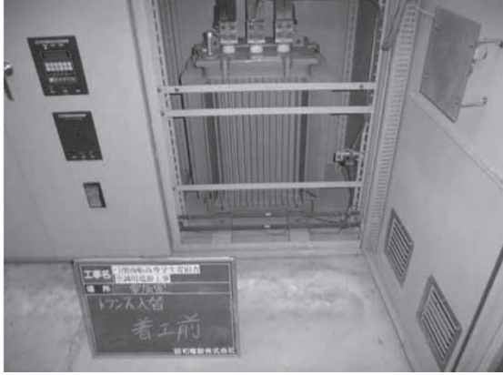
1-1 着工前写真(学生寄宿舍変圧器)
