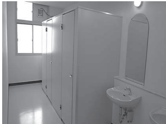
2-2 完成後写真(第1体育館女子便所)
