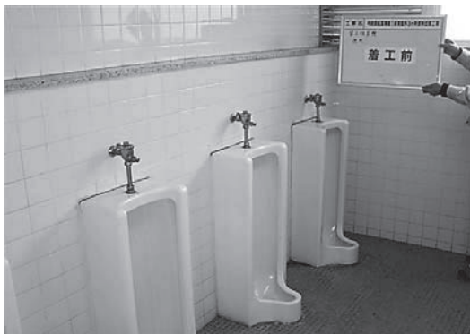
3-1 着工前写真(第2体育館便所)
