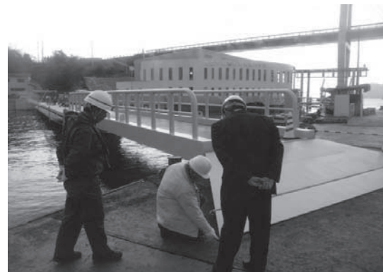
2-2 完成後写真(実習船係留場可動橋)
