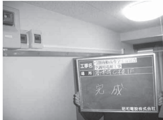
2-2 完成後写真(学生寄宿舍高学年棟居室)
