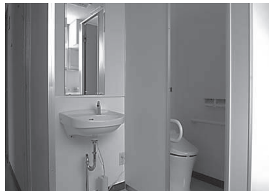
3-2 完成後写真(第2体育館男子便所)
