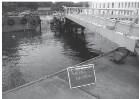
2-1 着工前写真(実習船係留場可動橋)
