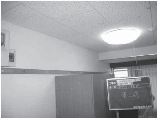
2-1 着工前写真(学生寄宿舍高学年棟居室)
