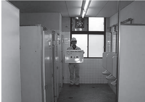
1-1 着工前写真(第1体育館男子便所)
