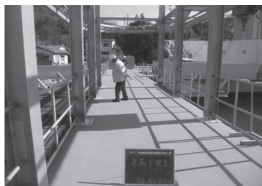
3-2 完成後写真(実習船係留場固定橋)
