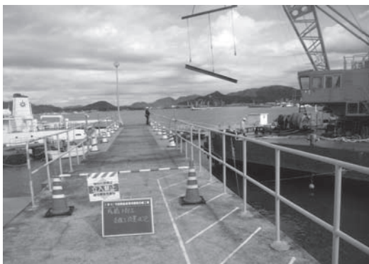
3-1 着工前写真(実習船係留場固定橋)
