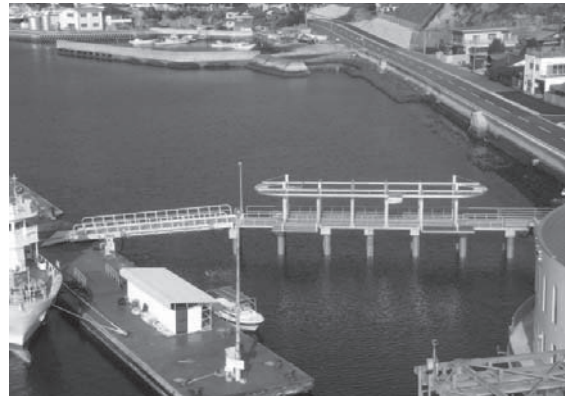
1-2 完成後写真(実習船係留場棧橋)
