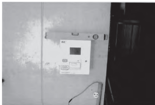
2-2 完成写真 （校舎地区実習工場 ボイラー室地下タンク用 高精度液面計測器へ取替）
