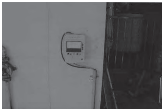
2-1 着工前写真 （校舎地区実習工場 ボイラー室地下タンク用 液面計測器）
