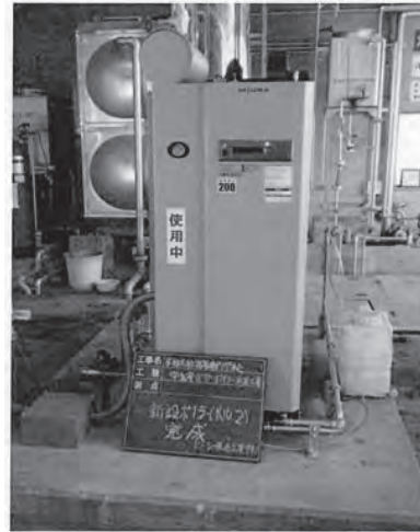
1-2 完成検査写真 （日比地区食堂棟 ボイラー室新小型貫流ボイラー）
