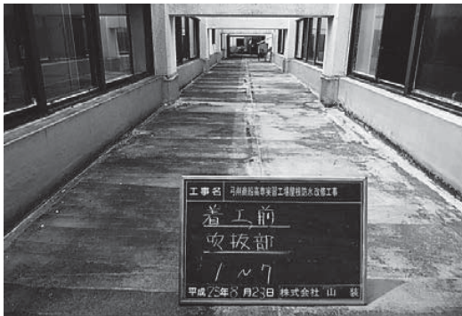
1-3 着工前写真(屋上吹抜け凹部位)
