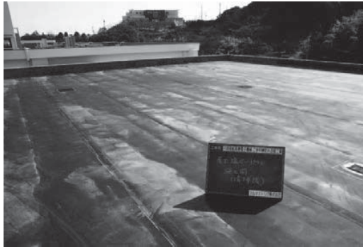
2-1 着工前写真(屋上平場部位)
