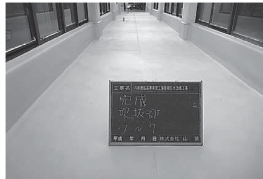
1-4 完成写真(屋上吹抜け凹部位)
