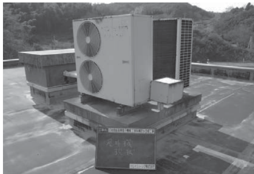
2-3 着工前写真(屋上屋外空調機架台部位)
