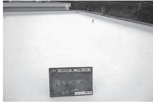
2-2 完成写真(屋上平場部位)
