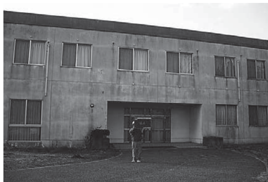
3-1 着工前写真 (建物正面)
