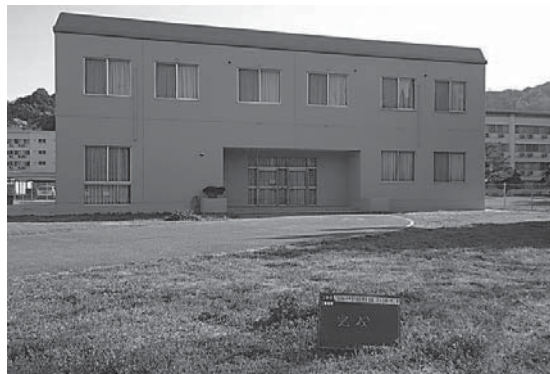
3-2 完成写真 (建物正面)
