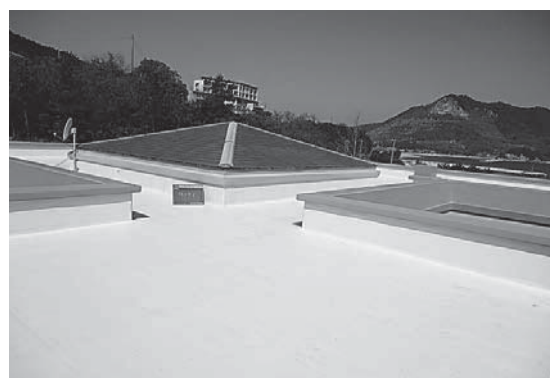
3-4 完成写真 (建物屋上)
