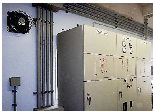
3 完成写真 (受電室/内部改修)
