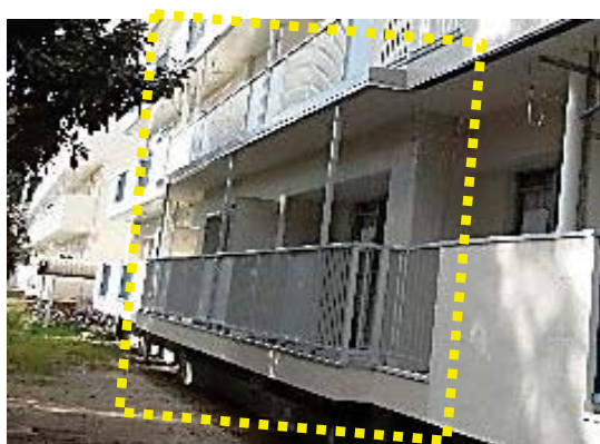
2 完成写真 (耐震+外壁改修)
