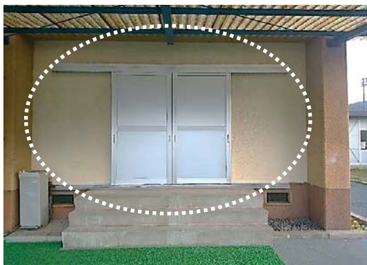
2 完成写真 (第2体育館)
