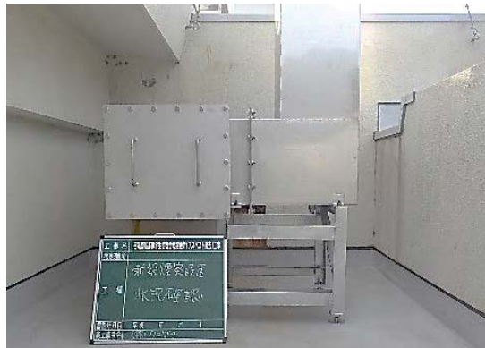
3 完成写真 （新設煙突）
