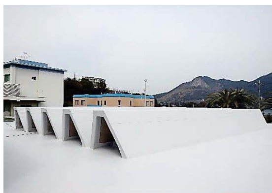
2 完成写真 (食堂室換気屋根・屋上防水改修)
