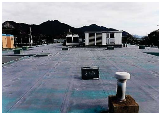
1 着工前 (中央ファンルーム附近・屋上)
