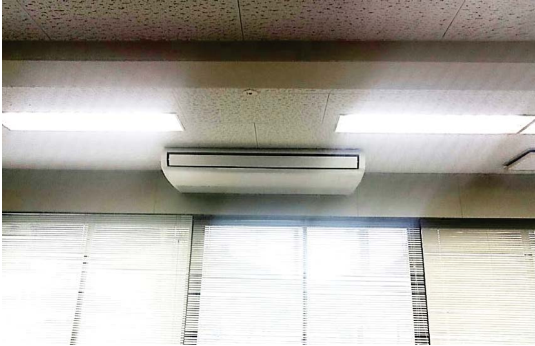
1 完成写真 (空調機取付状況)
