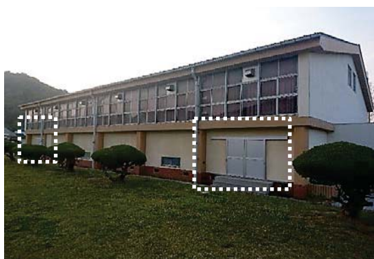
1 完成写真 (第2体育館)
