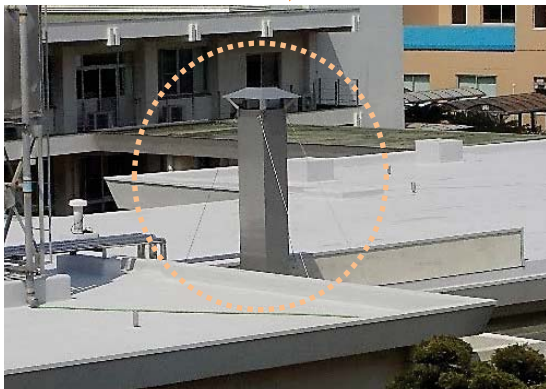
2 完成写真 （新設煙突）
