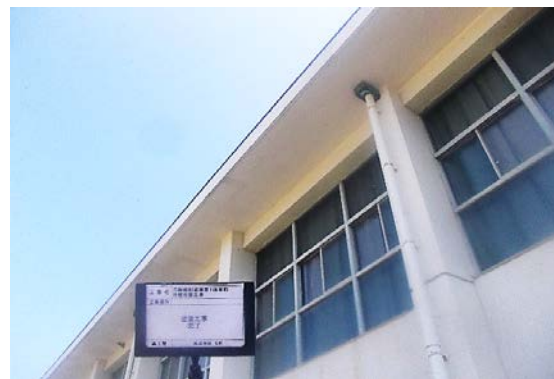
4 完成写真 (北面軒下)
