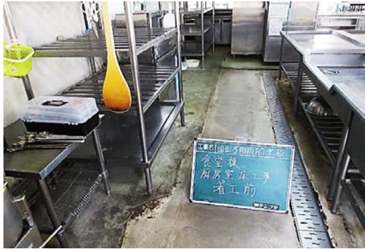
1 着工前 (シート剥離状況)
