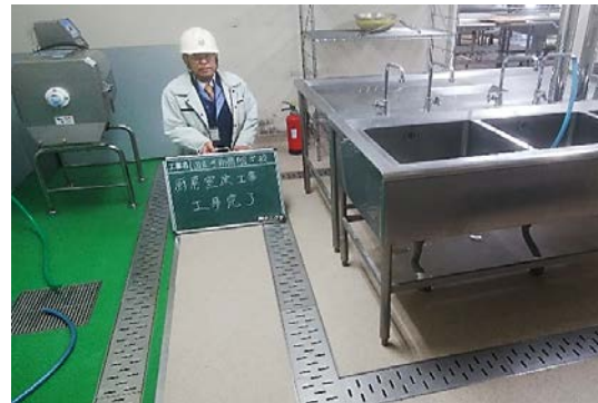
4 完成写真 (グリップコート仕上)
