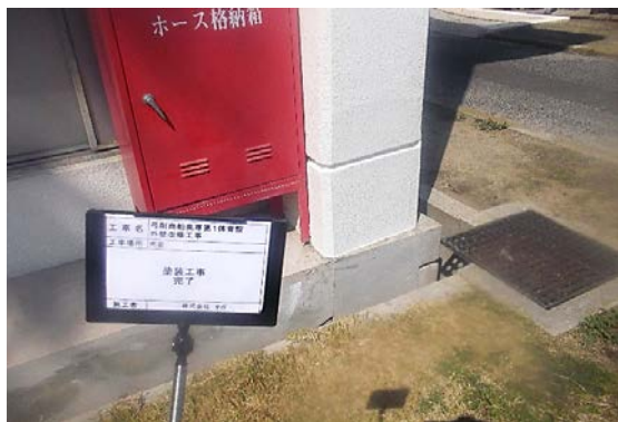
3 完成写真 (南面柱)
