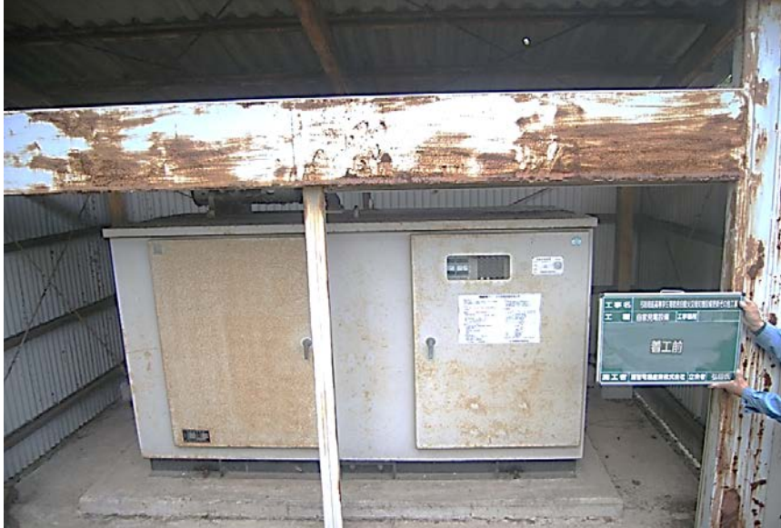
1 着工前 (自家発電設備設置状況)
