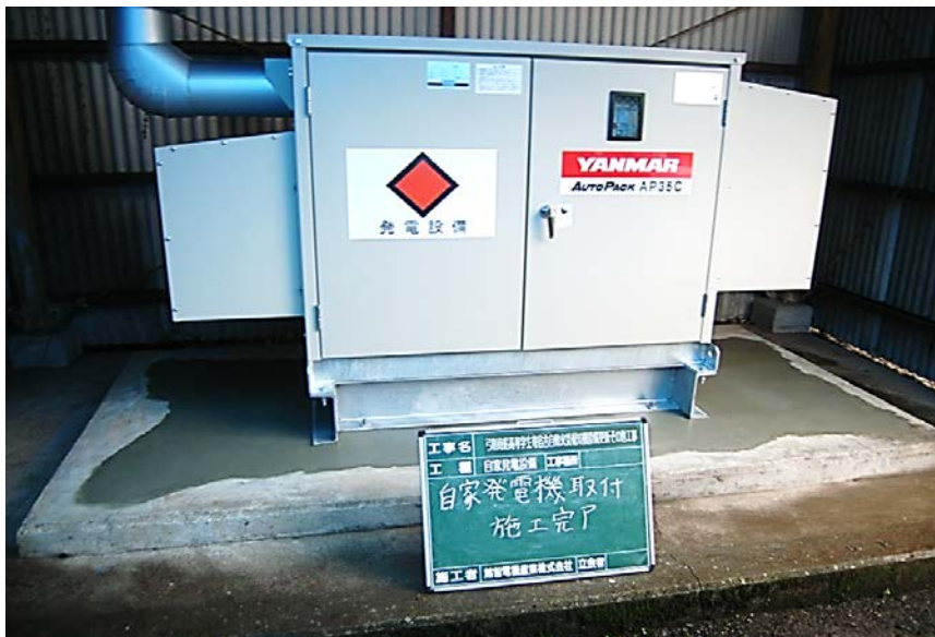
2 竣工 (自家発電設備設置状況)
