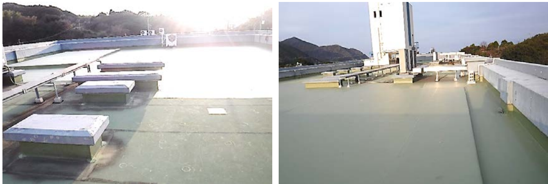
2 完成写真 (屋上防水全景)
