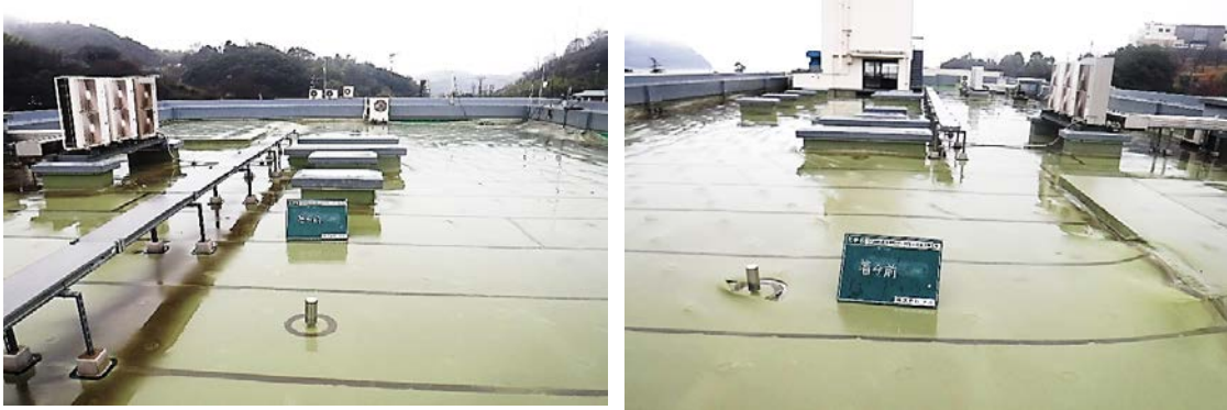
1 着工前 (屋上防水全景)
