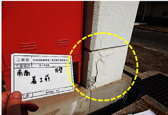
1 着工前 (南面柱)
