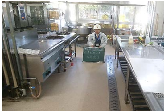
3 完成写真 (抗菌シート仕上)
