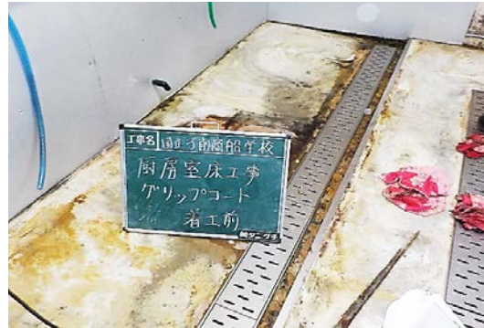
2 着工前 (コンクリート汚濁状況)
