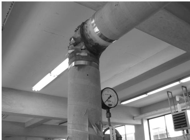
Fig.16 腐食している管
