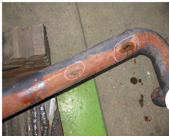
図6 腐敗して穴が開いたパイプ
