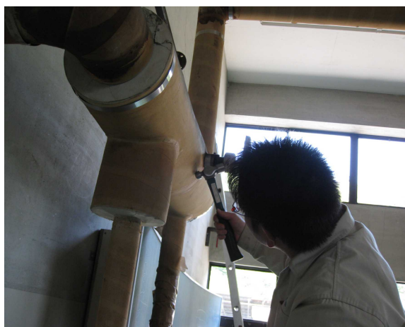
図8 バルブを取り外している様子
