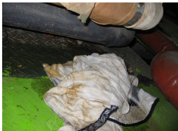
図5 水漏れしたパイプ
