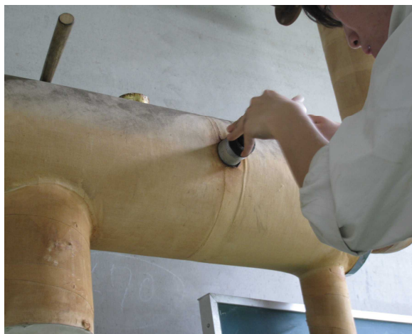
図10 パッキンを取り除いている様子
