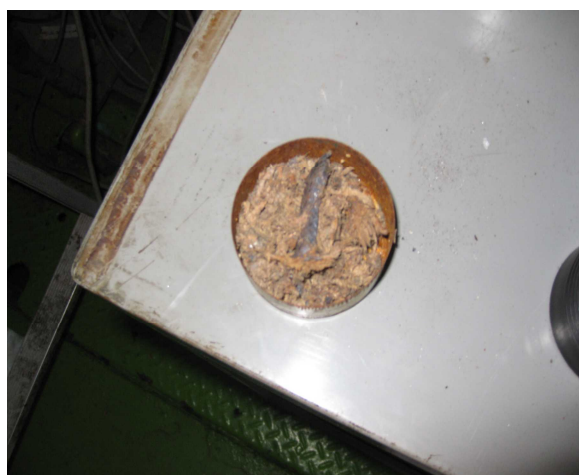
図11 硬化したグラウンドパッキン
