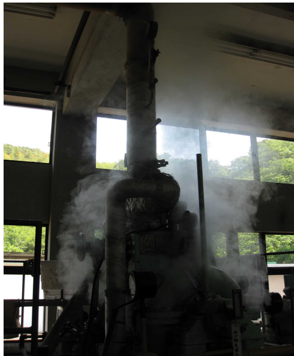
図7 蒸気を取り入れての試運転の様子
