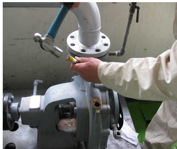
図2 循環水ポンプの分解
