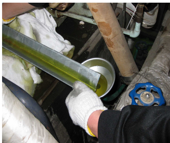
図13 最初の方に抽出されたオイルの様子
