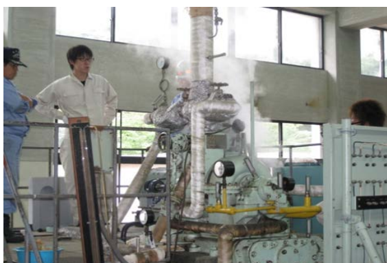
図2 試運転中の様子
