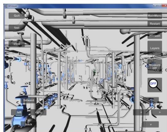
図 4 機関室中央部のパイプライン
