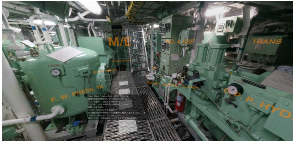
図5 機関室ウォークスルーシステムの画面表示
