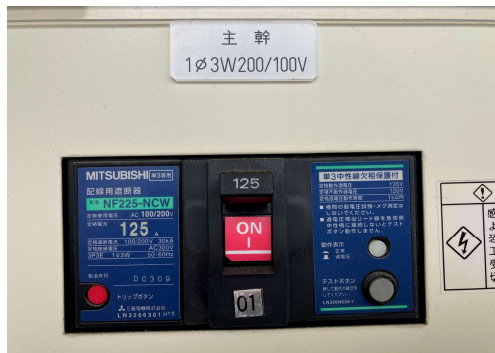
今年度の工事（3階）未改修
